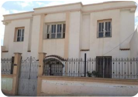
Figure 116: Photo de la crèche Source : Auteur, Mars 2021
