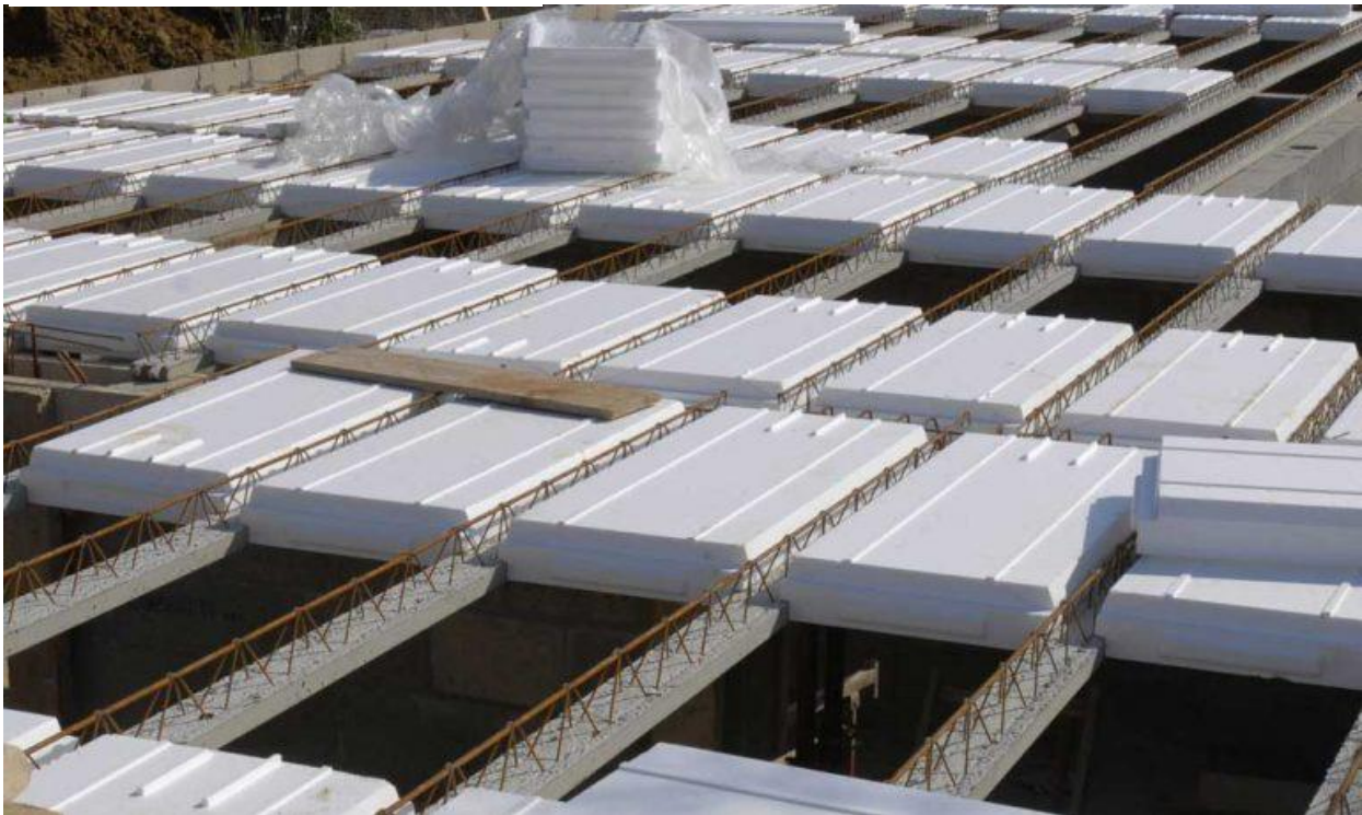
Fig.II.2. Exemple De Hourdis En Polystyrène.
