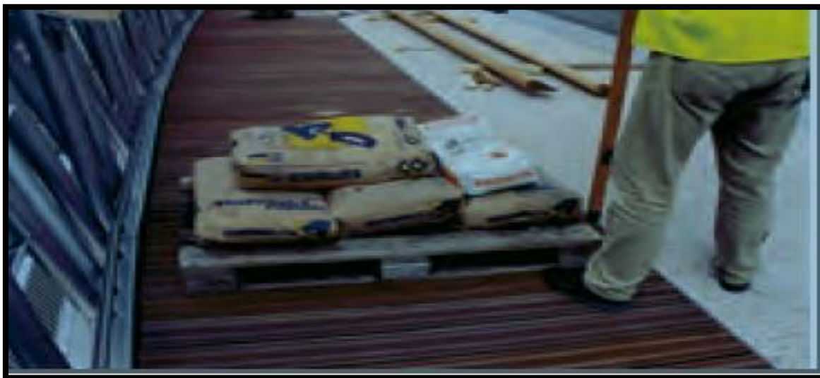
Fig V.4 : Chargement d'un trottoir
