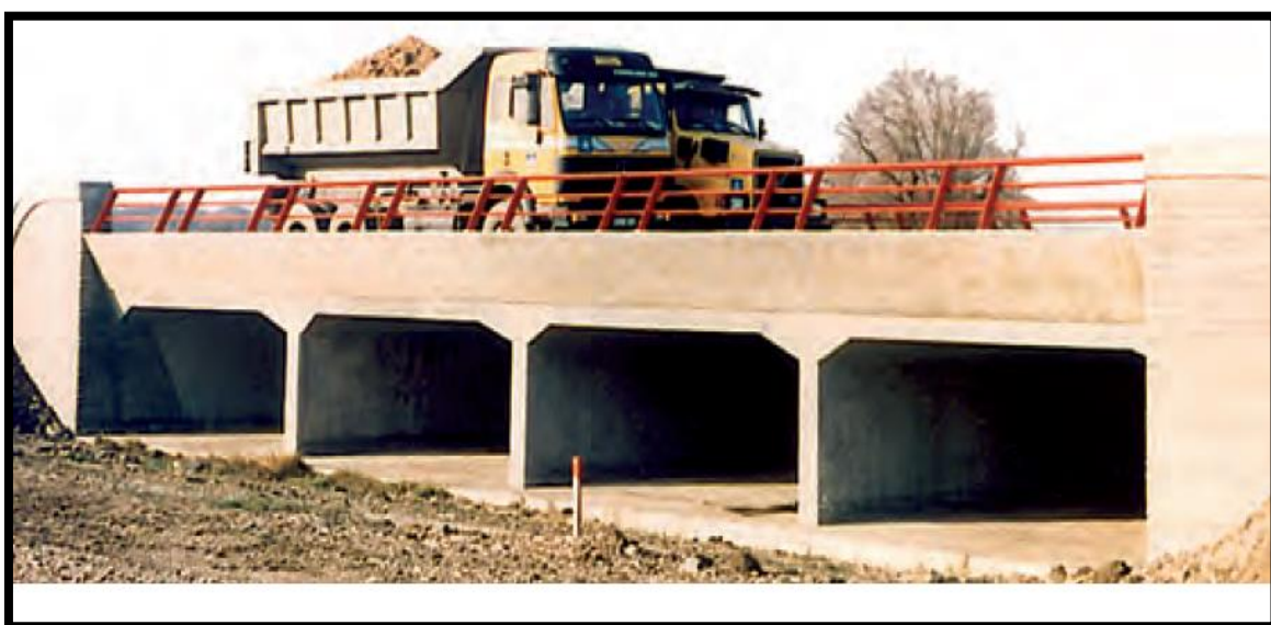
Fig V.3 : Essai de chargement d'un dalot
