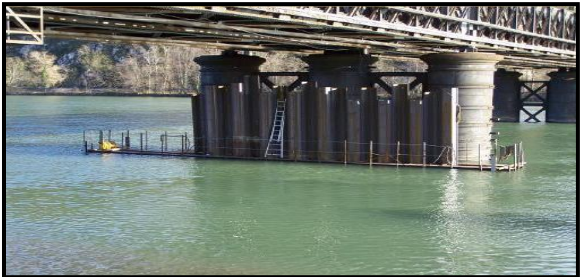
Fig I.4 : Pose de batardeaux en palplanches
