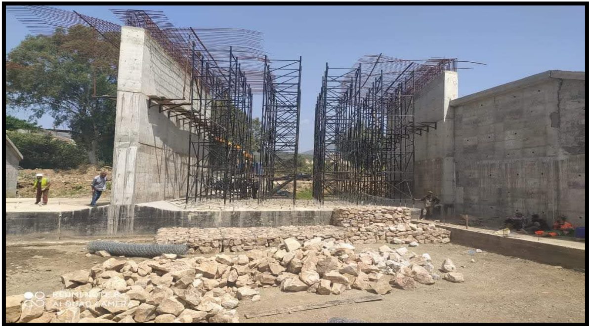
Fig I.3 : Installation d'un matelas de gabions (El Kseur-OA1 2 )
