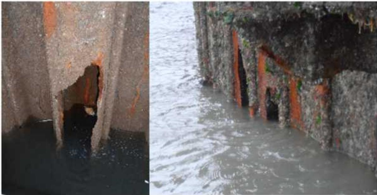
**Figure I-4 :** l'effet de la corrosion sur les palplanches [2]
