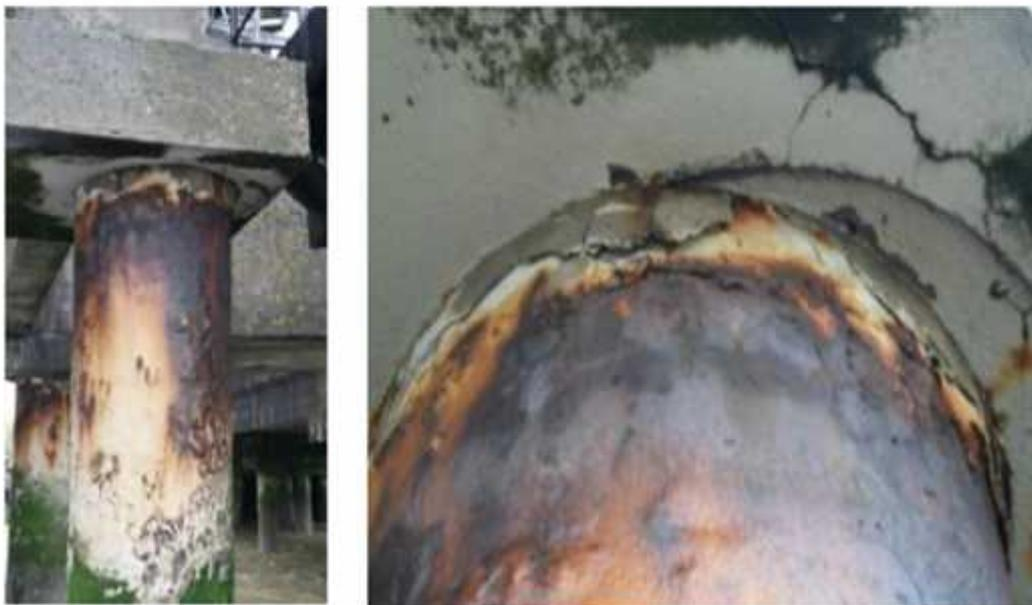
**Figure I-5 :** l'effet de la corrosion sur les têtes des pieux [2]
