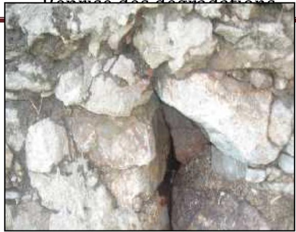
Photo n°02 – Déchaussement du parement en maçonnerie avec présence fissures de petites cavités
