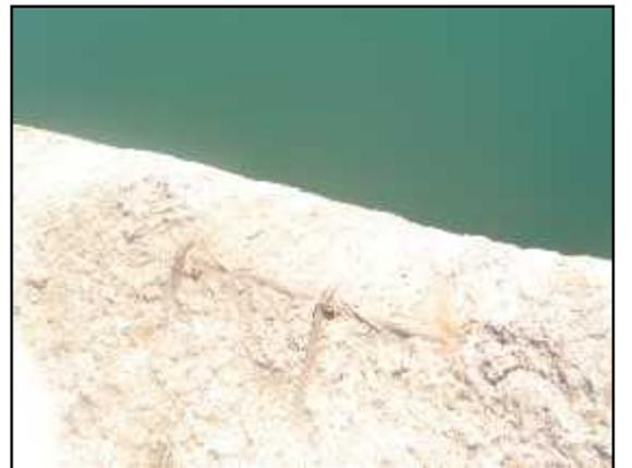
Photo n°09 - Dégradation du béton de nez de quai avec apparition des armatures
