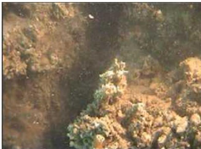
**Figure IV-3** : dégradation de la partie sous-marine (écartement des joints)
