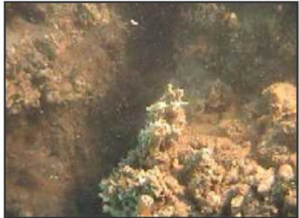
Photo n°04 - Représentant un écartement des joints de haut en bas laissant apparaître des cavités au niveau du poste 12
