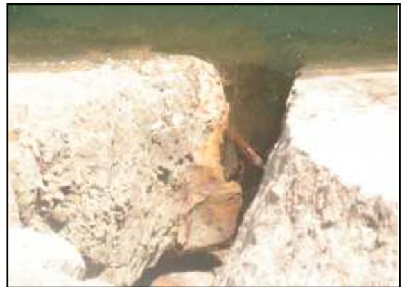
Photo n°08 - Cassure de la poutre en béton n°2 du quai de la Passe – poste 14
