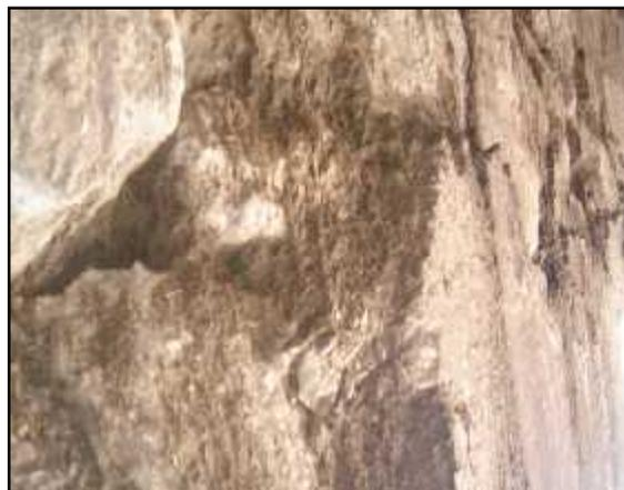
Photo n°01 – Déchaussement de pierres de maçonnerie
