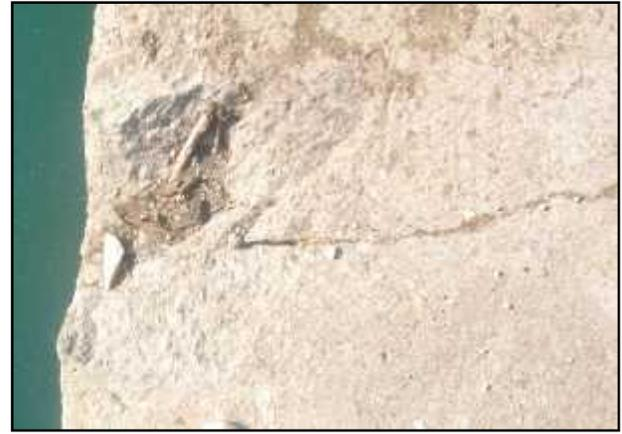
Photo n° 07 - Fissure profonde sur toute la largeur d'un élément en béton du quai de la Passe – poste 14
