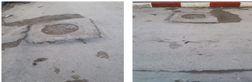
Figure III-14 : Quelques tampons surélevés dans la ville de Bejaia.
