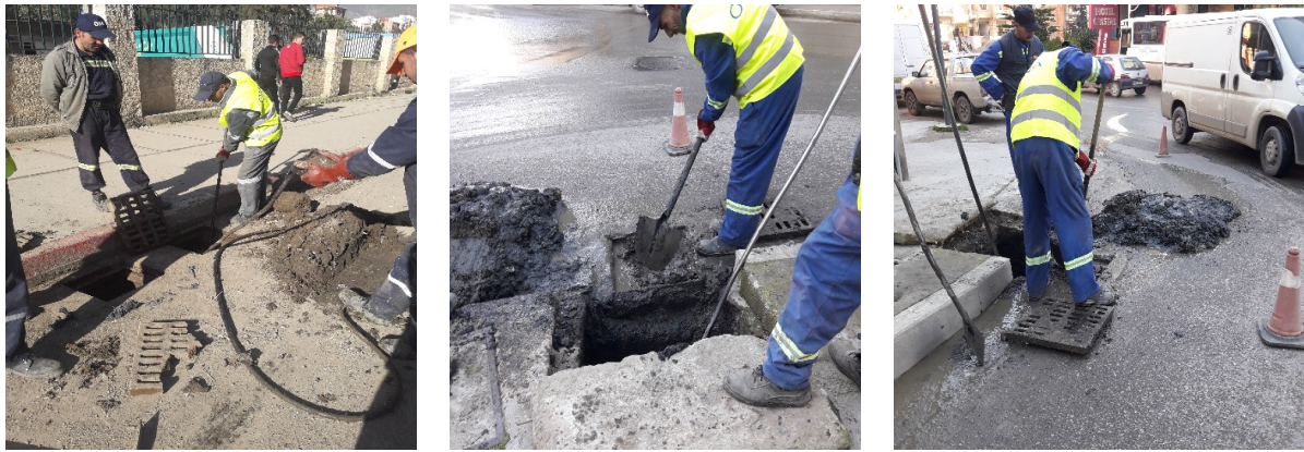
Figure III-21 : Quelques opérations de curage curatif sur les ouvrages de surface dans la ville de Bejaia.
