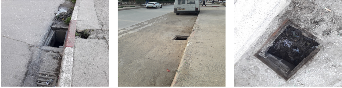
Figure III-17 : Quelques avaloirs sans grille dans la ville de Bejaia.
