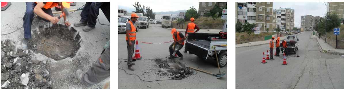
Figure III-16 : Exemples d'opérations de l'enlèvement du bitume couvrant les regards.
