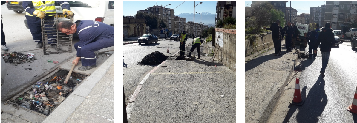
Figure III-20 : Quelques opérations de curage préventif sur les ouvrages de surface dans la ville de Bejaia.
