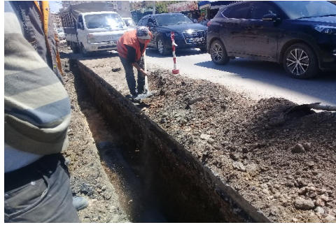
Figure III-22 : Exemple de remplacement d'une conduite dans la ville de Bejaia.
