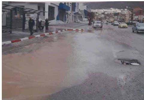
Figure III-18 : Exemple d'un avaloir mal positionné dans la ville de Bejaia.
