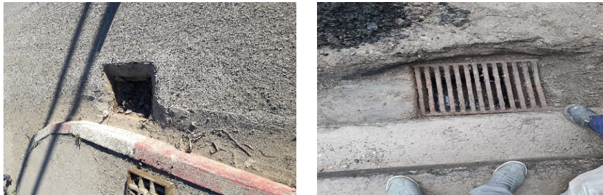
Figure III-19 : Quelques avaloirs en nid de poule dans la ville de Bejaia.
