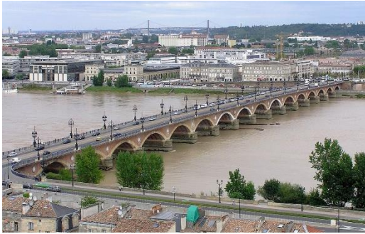
Figure 11 : le pont Saint Pierre
