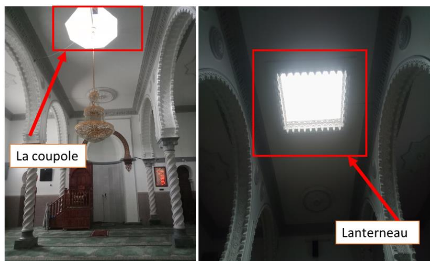
Figure 54: ouverture de toiture mosquée sidi soufie
