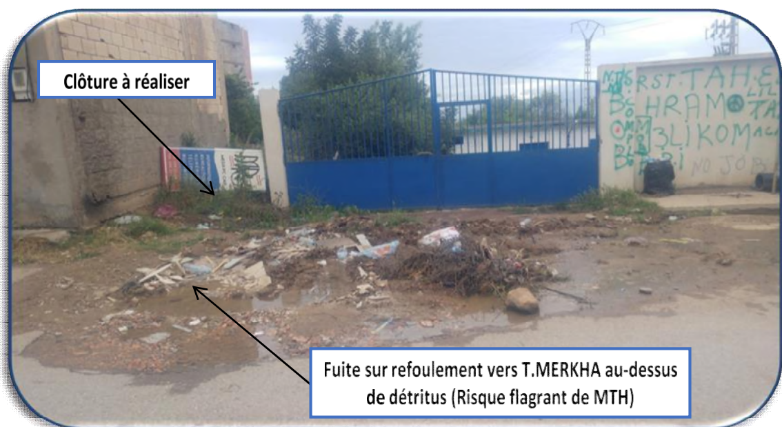
Figure III-1. Vue entrée extérieure de la station de pompage SMINA.
