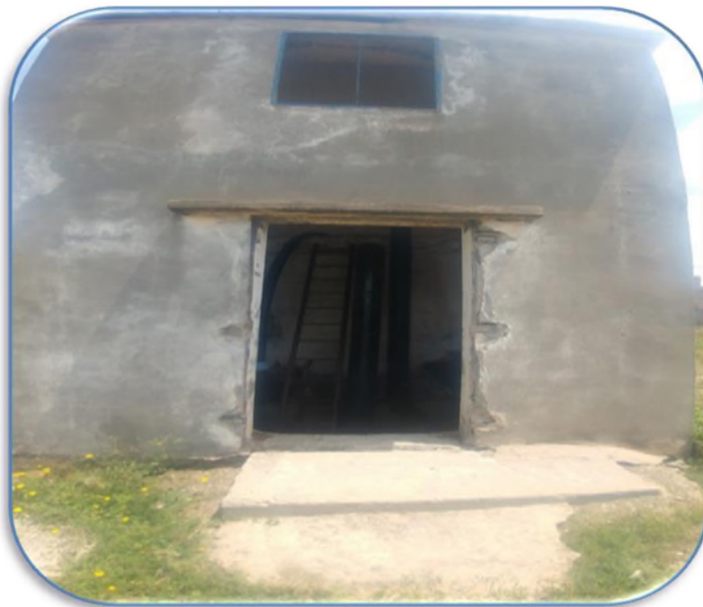
Figure III-17. Chambre de vannes : sans peinture et sans porte d'entrée.
