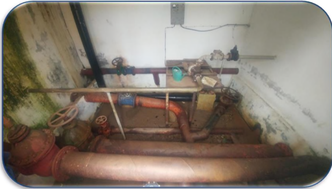
Figure III-6. Vue intérieure de la chambre de vannes.
