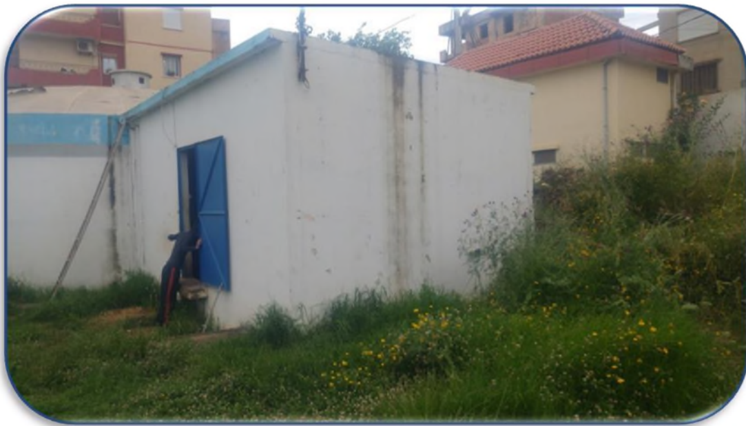
Figure III-5. Vue extérieure de la chambre de vannes du réservoir 1000 m 3 .
