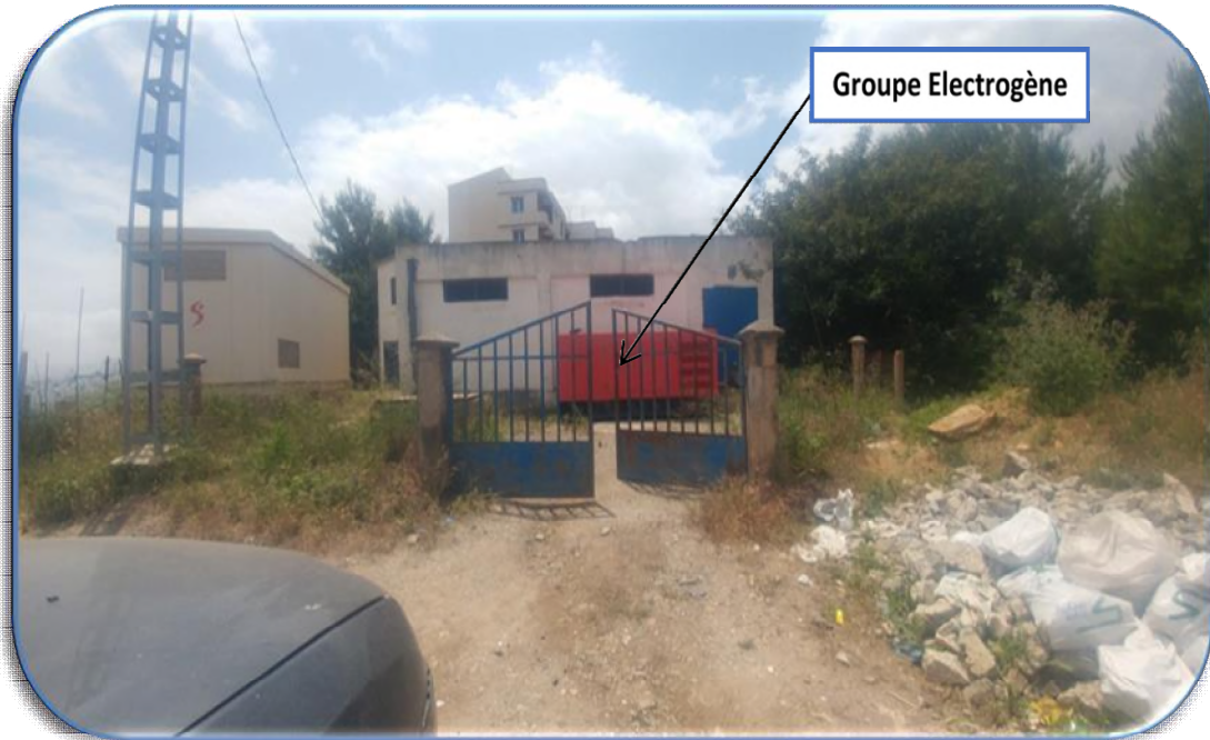
Figure III-7. Vue d'ensemble de la station : Entrée à l'état de piste, gravats aux alentours de l'ouvrage Clôture en grillage de faible hauteur.
