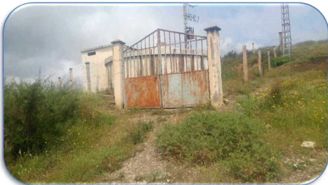
Figure III-13. Vue générale de l'extérieur.
