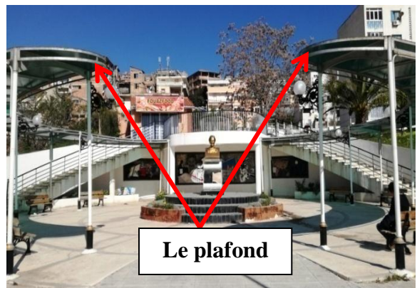
Figure.2. 8 : Le plafond de la place « Said Mekebel » Source : Auteurs, 2021
