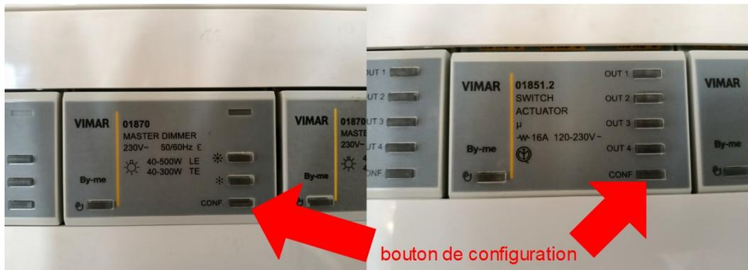
Figure IV.18. Bouton configuration sur les actionneurs Vimar
