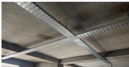
Figure IV.1. Chemins de câbles utilisés dans le bâtiment
