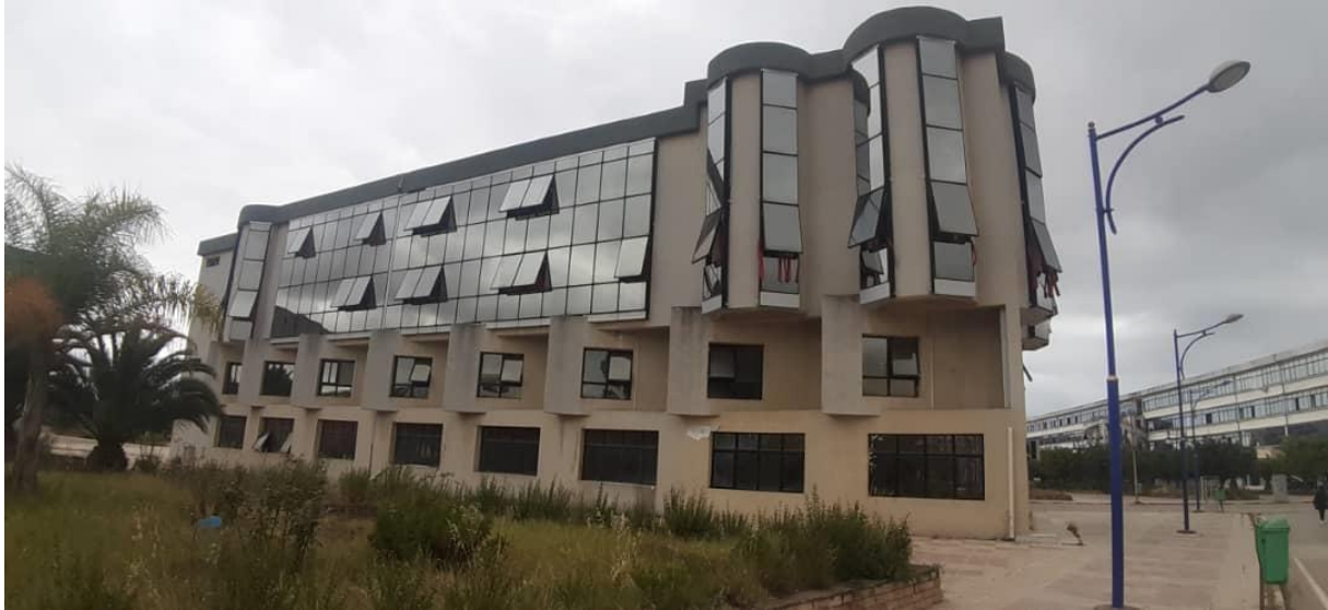
Figure 57 : façade ouest de la bibliothèque.
