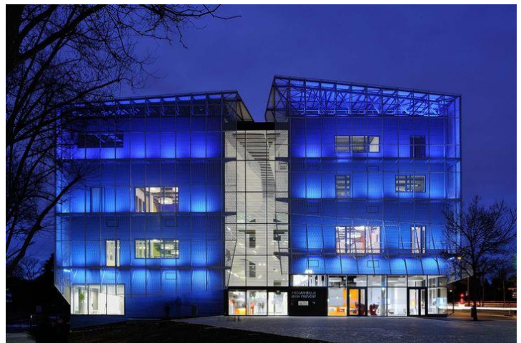
Figure 101 : vue sur la médiathèque.
