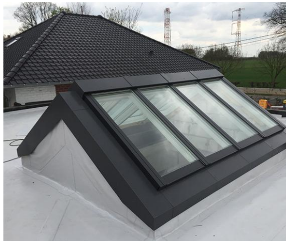
Figure 13 : Exemple de l'éclairage zénithal de type lanterneau
