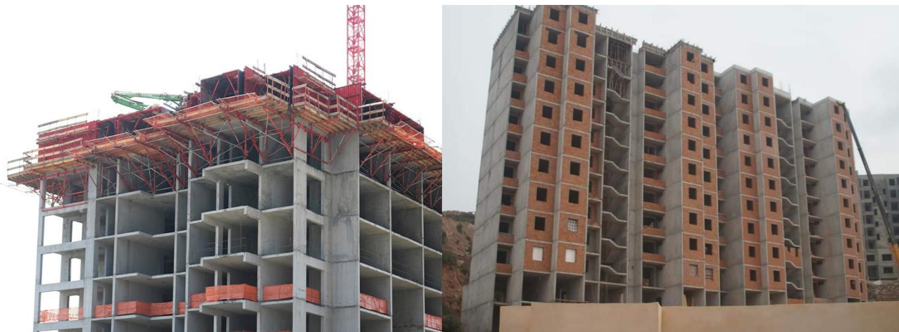
Figure I-2 : Aperçu du système coffrage tunnel sur chantier.
