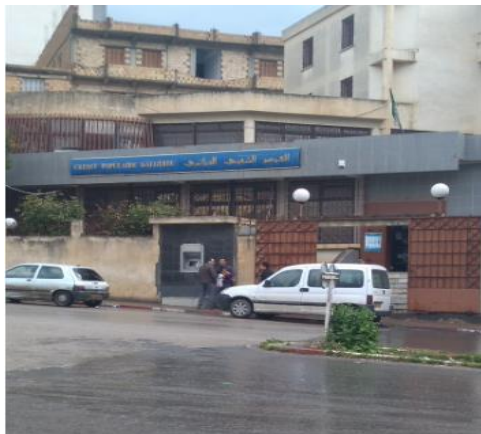
Figure 63: caisse des assurances El-kseur.
