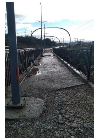
Figure 81: pont piéton existant.
