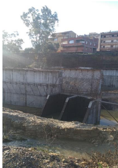
Figure 79: pont mécanique en cours de réalisation.
