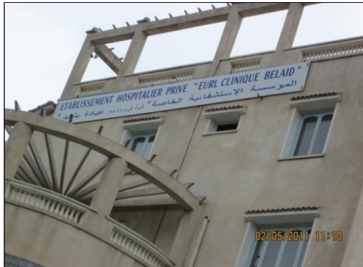
Figure 61: établissement hospitalier "EURL Clinique BELAID".
