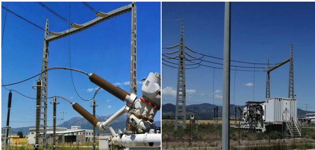
Figure IV. 15: les points de connexion HT
