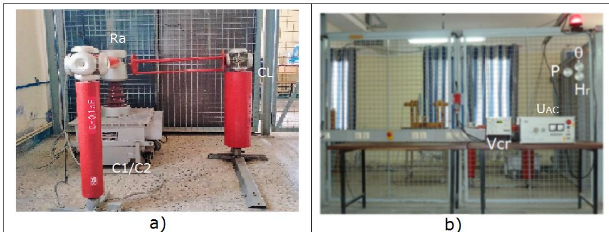
Fig. III. 2: Photos des éléments du circuit électrique de l'unité de commande et de la cellule de mesure (a: Circuit de mesure, b: Cellule de mesure, dispositif et appareillage de commande)
