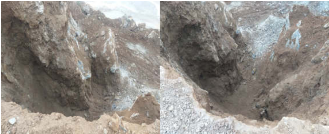
Figure IV.6 : débarrasement des poches d'argile (au talus du gradin) par une pelle excavatrice (photo prise à Adrar Oufarnou).
