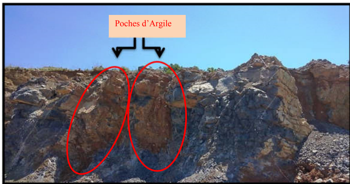
Figure IV.5 : présentation des poches d'Argile au talus du gradin (photo prise à Adrar Oufarnou).
