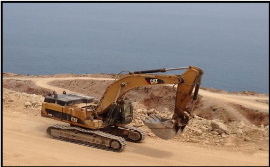
Figure II.4 : Pelle excavatrice CAT 345D (prise à Adrar Oufarnou).
