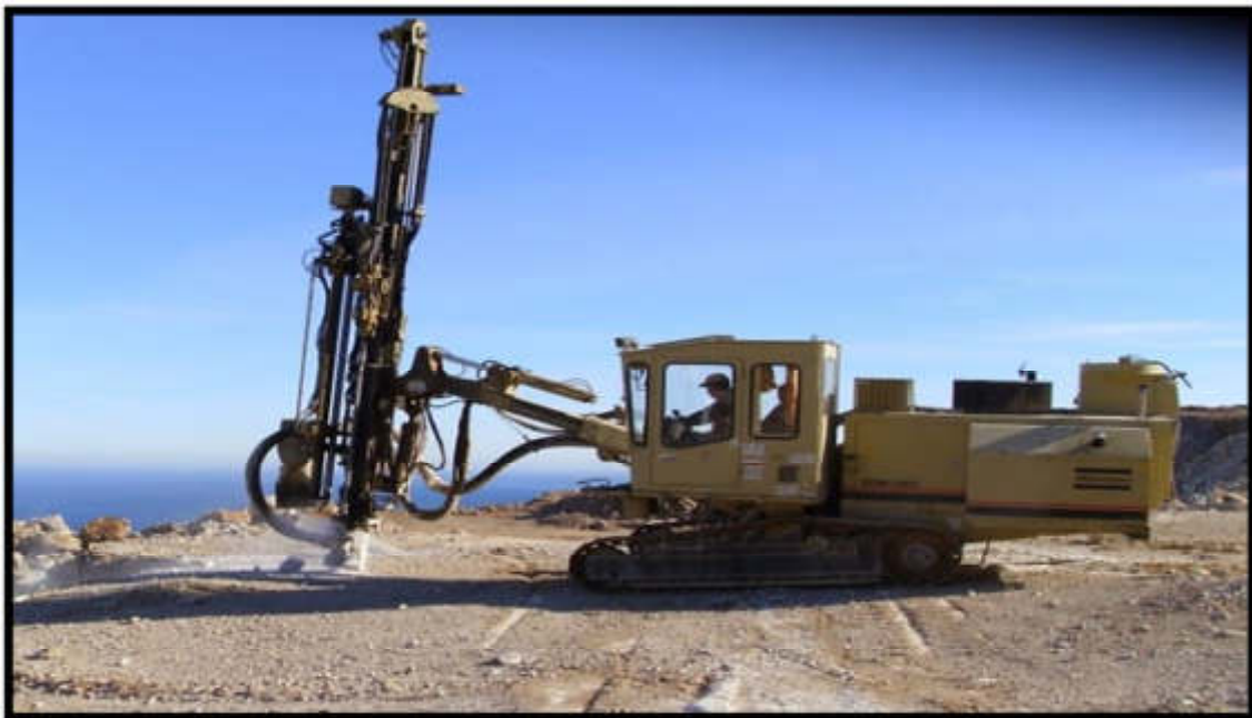
Figure III.3 : Sondeuse ATLAS COPCO 580Y (prise à Adrar Oufarnou).
