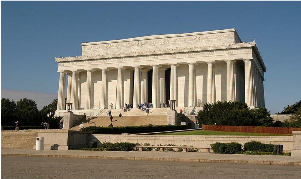
Figure 4 : Le Lincoln Memorial, construit principalement en marbre de Yule et en calcaire de l'Indiana.
