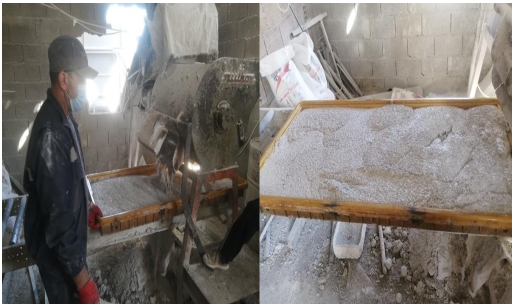
Figure 19 : Moulage des dalles (prise le 04/04/2021)
