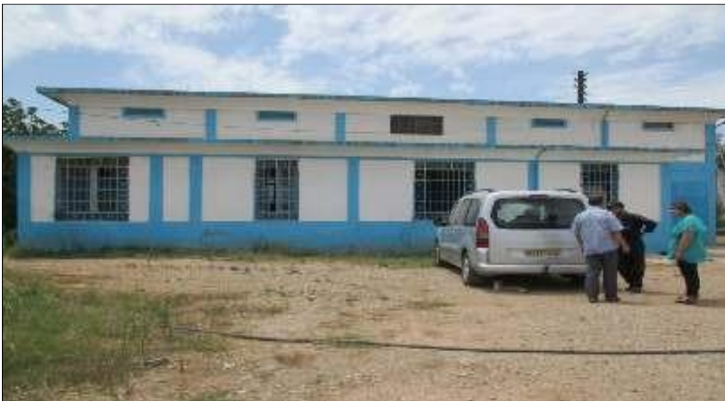
FigureII-05 : Vue d'extérieur de la station de pompageSOUK EL HAD
