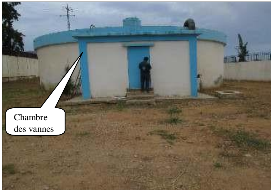
FigureII-11: Vue du réservoir 1000m 3
