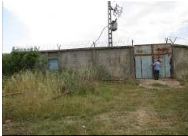
FigureII -04 Vue Général du forage (inaccessible).
