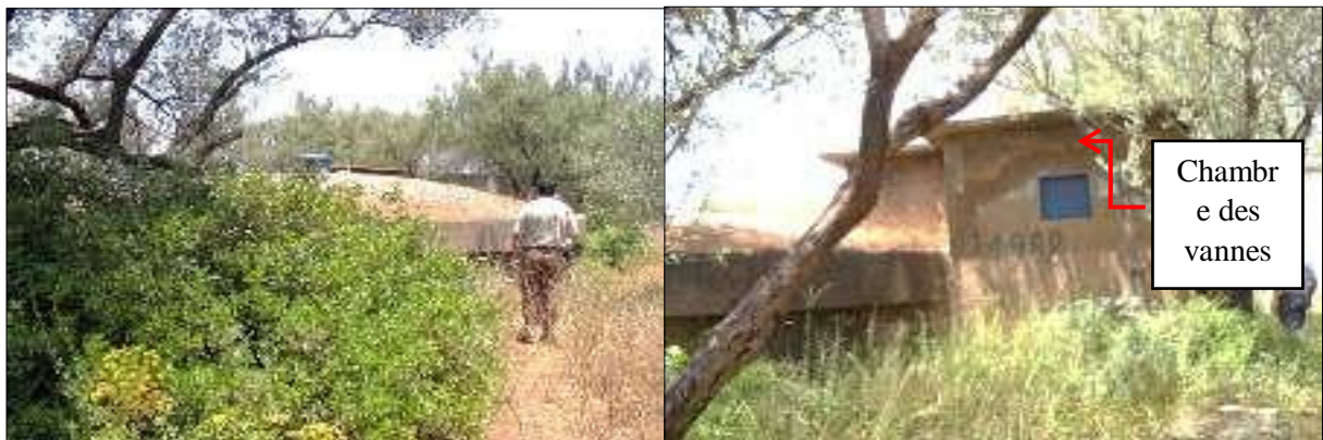
FigureII-21 : Vue général du réservoir 200m 3 enterré
