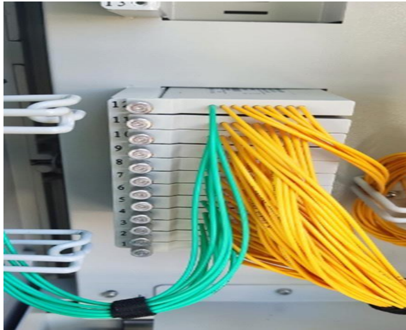
Figure I.14 : Coupleur optique (splitter).
