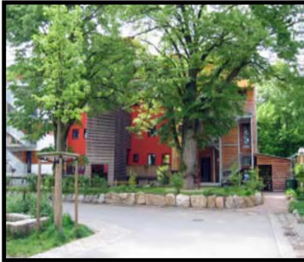
Figure 40 vu sur un bâtiment dans le quartier source http://www.maison-passive-nice.fr/pdf/Vauban_Fribourg.pdf
