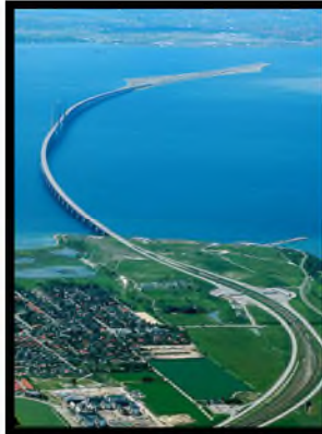
Figure 14 Le pont de l'oresund source https://www.pinterest.com/
