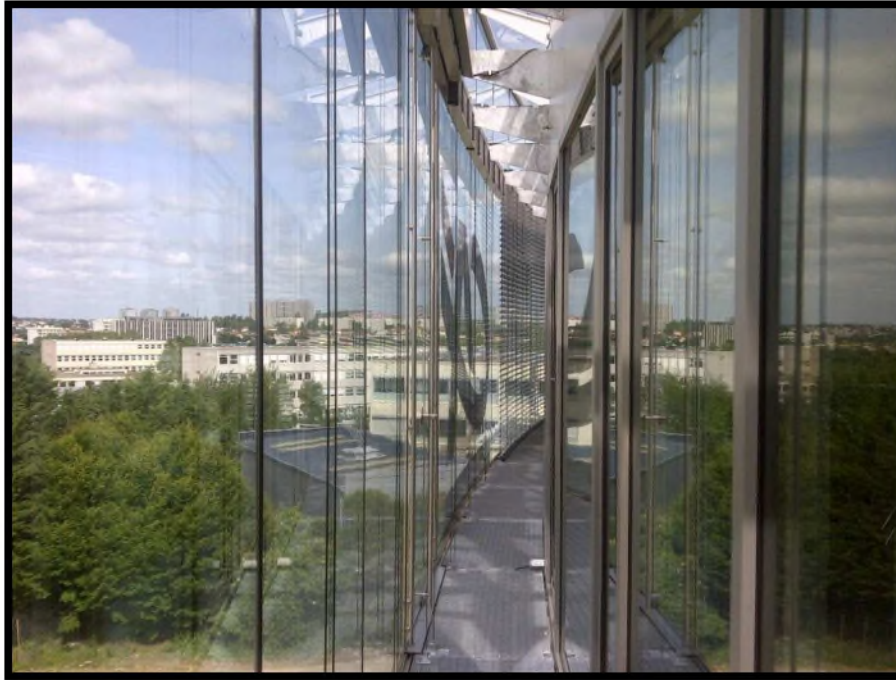
Figure 7 Façade à double peau, source : https://www.souchier-boullet.com/gestion-energetique/systeme-pilotage-intelligent/pilotage-facade-double-peau/
