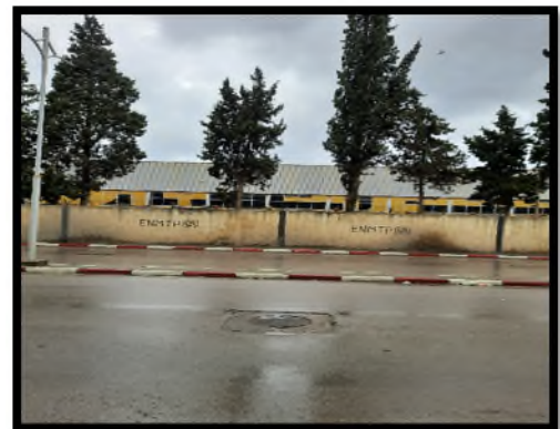
Figure 68 vu sure un hangar industriel source auteur
