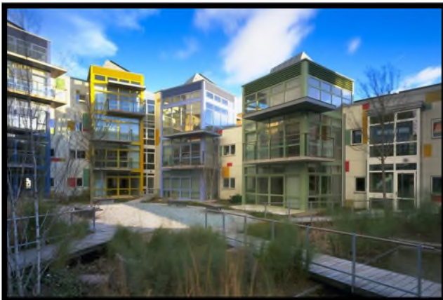
Figure 29 vu sur les habitations de tango housing source http://www.archnewsnow.com
