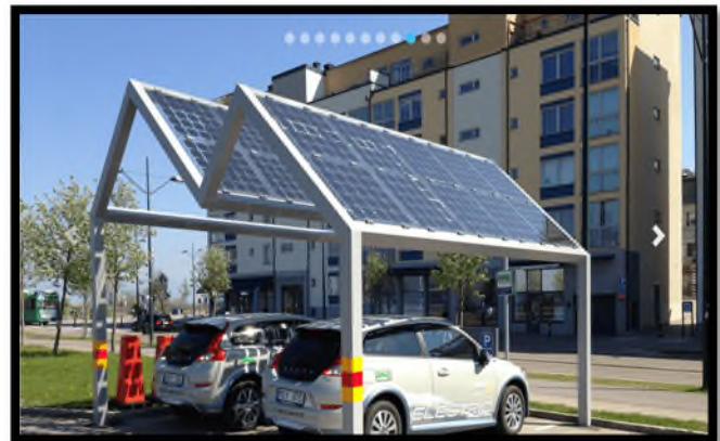
Figure 26 vue sur une station des véhicules aménagés par des panneaux solaires source https://use.metropolis.org/
