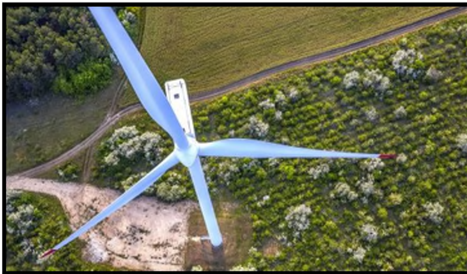
Figure 19 Éolienne qui alimentent le quartier de BO01 source https://www.theagilityeffect.com/
