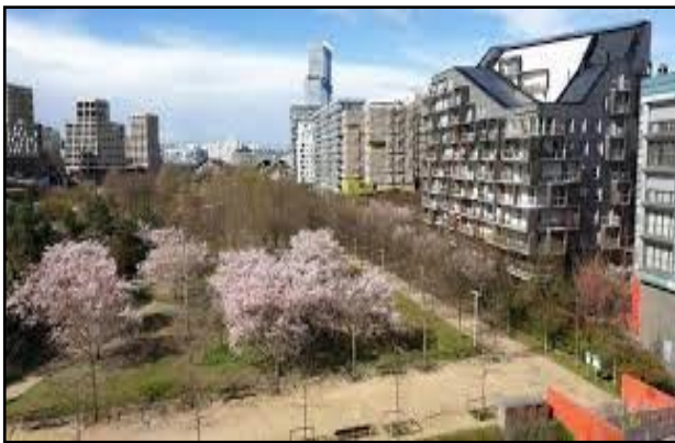
Figure 39, les panneaux Solaires Photovoltaïques de Clichy Batignolles. Source: didierfavre.com
