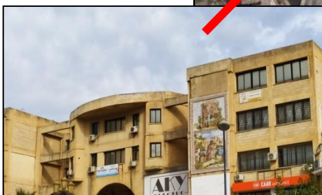
Figure 111. justesse visuelle dans le bâtiment commercial à la cité Somacob. Source: Prise photographique
