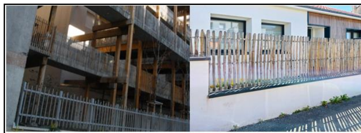
Figure 53, Les ganivelles en châtaigner sur les passerelles et ses anneaux métalliques de serrage du bâtiment pallium. Source : (Renaud., 2012)
