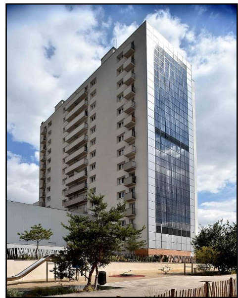
Figure 27, immeuble moderne avec les panneaux solaires. Source : dreamstime.com
