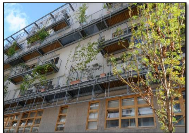
Figure 50, Façade double peau du bâtiment le Pallium. Source: micheldestot.fr
