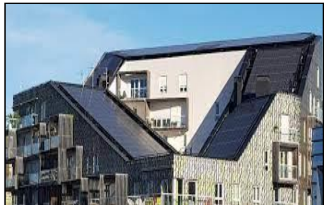
Figure 40, Panneaux Solaires Photovoltaïques, Clichy Batignolles vue de près. Source: didierfavre.com + Traitement personnel
