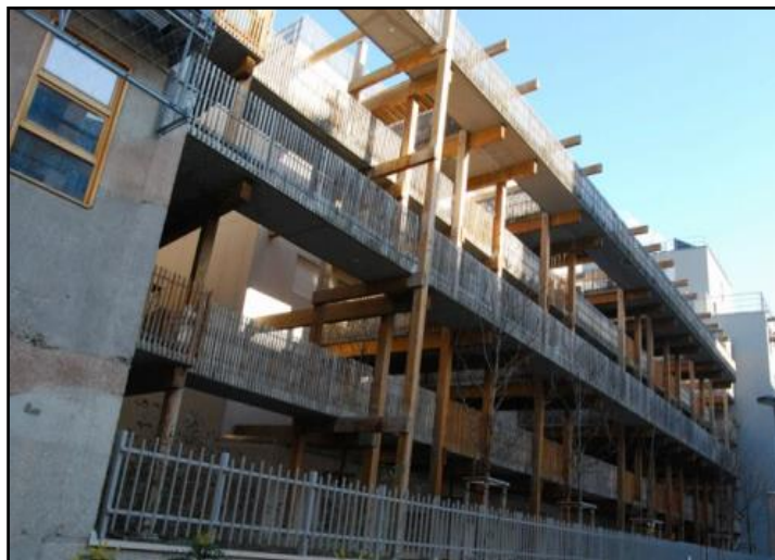
Figure 52, passerelle extérieur du bâtiment pallium. Source: (Renaud., 2012)
