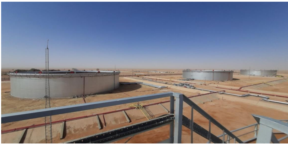
Figure I.6 : Les bacs de stockage (photo prise en entreprise).
