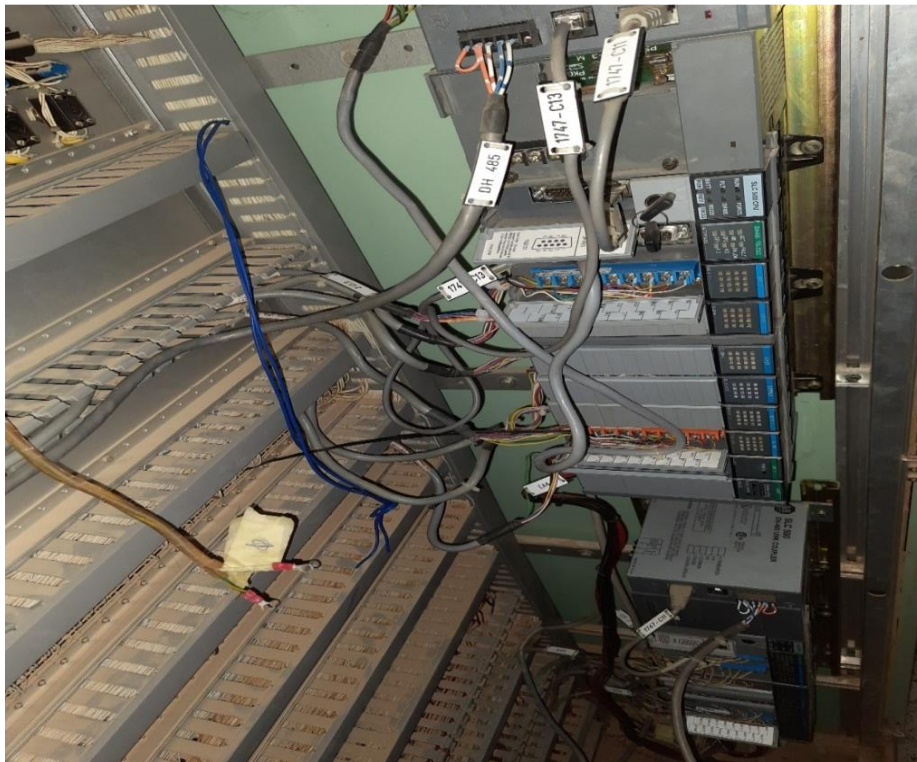
Figure I.17 : Technologie programmée avec l'automate SLC 500 (photo prise en entreprise).
