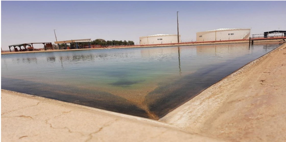
Figure I.13 : Un bassin d'incendie d'une capacité de 2100 m 3 (photo prise en entreprise).
