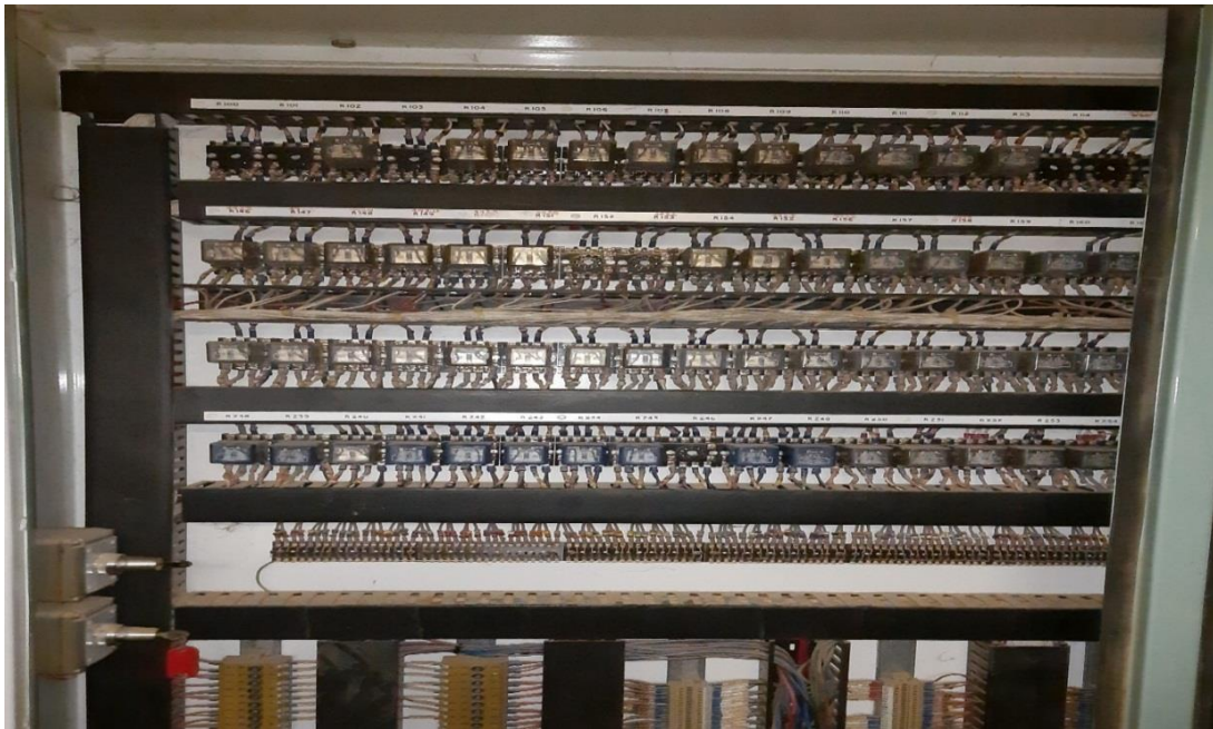
Figure I.15 : Technologie à relais existante dans la station (photo prise en entreprise).
