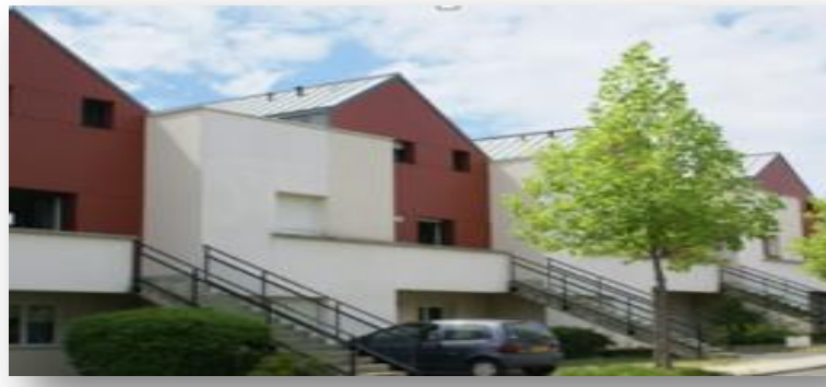
Figure 16 : L'immeuble individuel collectif, source : (Bougui & Abour, 2017-2018)
