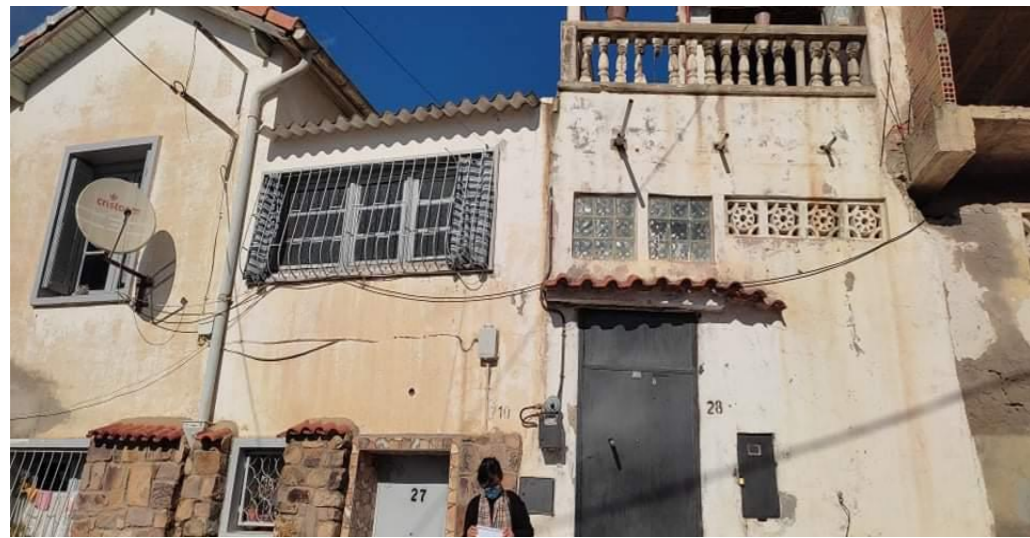
Figure 30 : la façade principale de la maison Karaman
