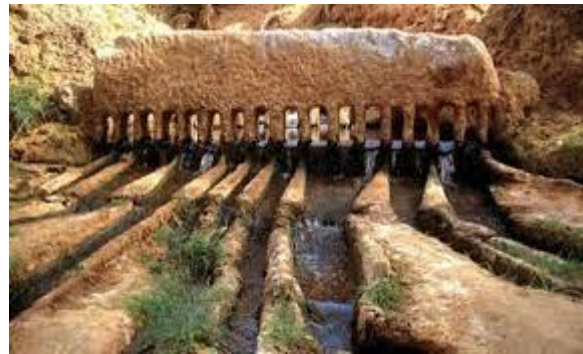
Figure 28 le système des eaux de fouggaras
