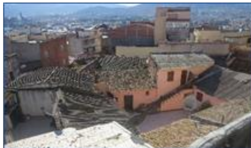
Figure 32 : la vue d'ensemble de la maison Bouzaraa à karamane
