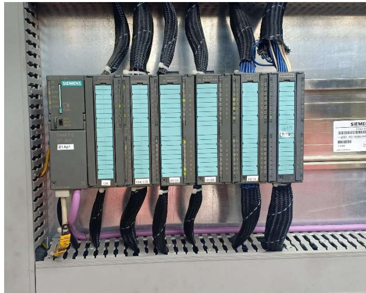
Figure II.1: Automate utilisé pour la machine COMBI-PAL (314C-2DP)
