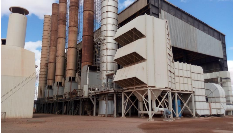
Figure I.04 : La centrale électrique d'IN AMENAS
