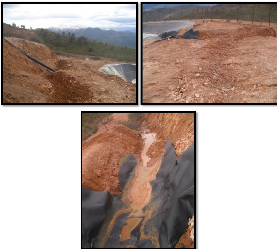
Figure A3. Drainage des eaux pluviales.
