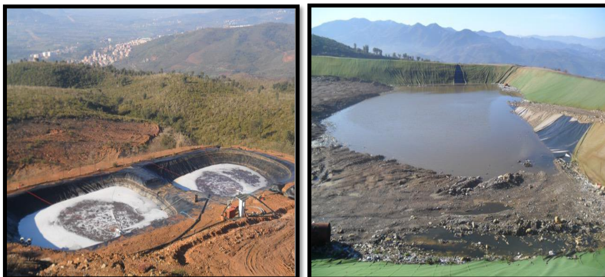
Figure A2. Etat du casier ainsi que les bassins de stockage des lixiviats.
