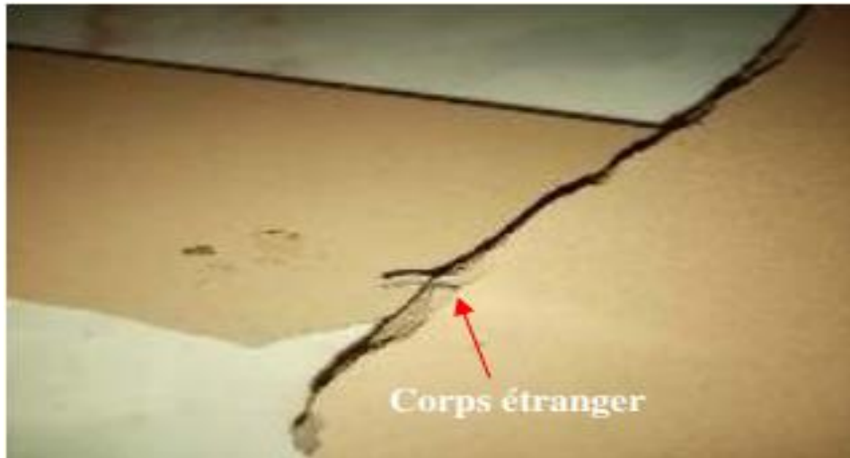
Figure V.2 Photo de présence d'un corps étranger dans un carreau
