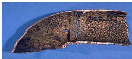
Figure I.6. Corrosion érosion d'un tube en cuivre véhiculant de l'eau.
