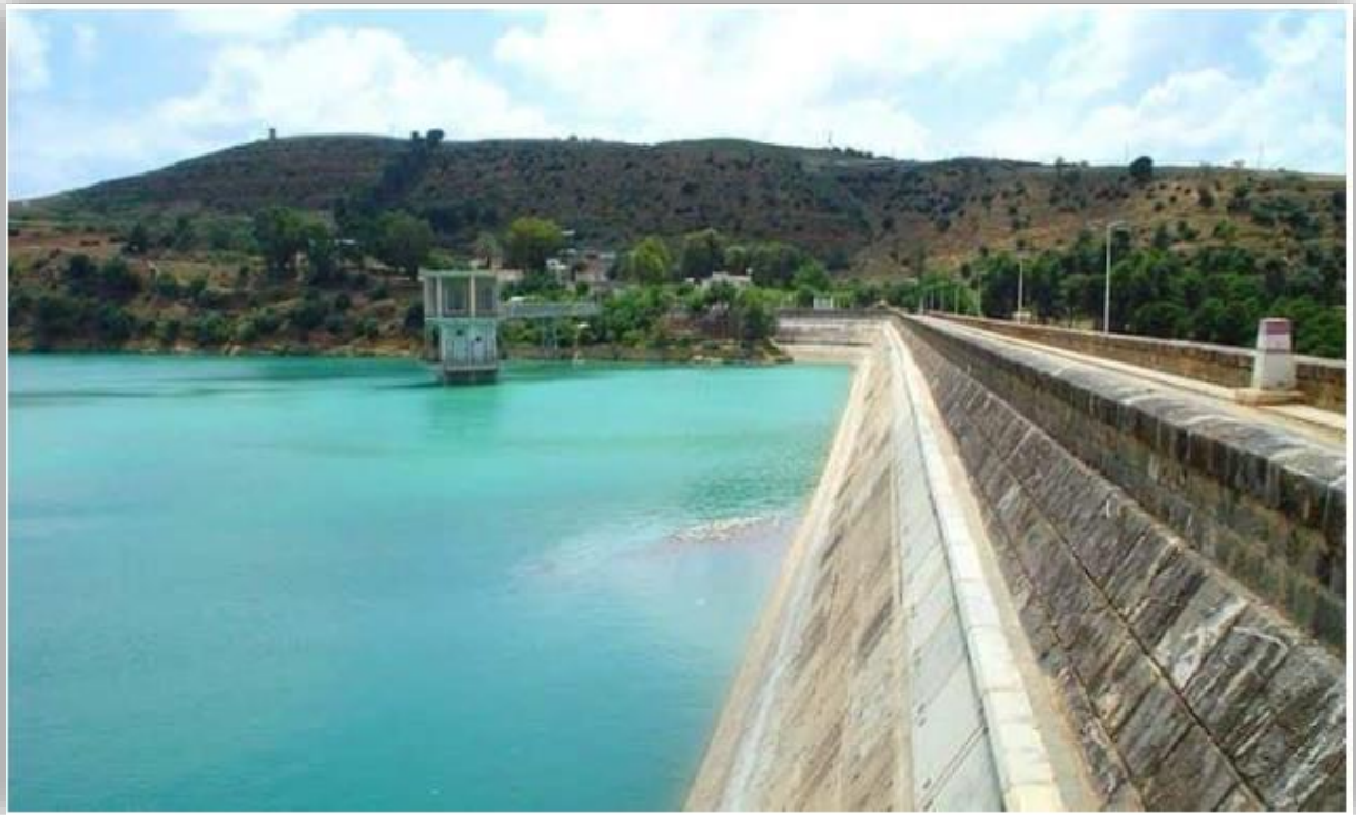
Photo (I .1) : Photo du barrage Tilesdit
