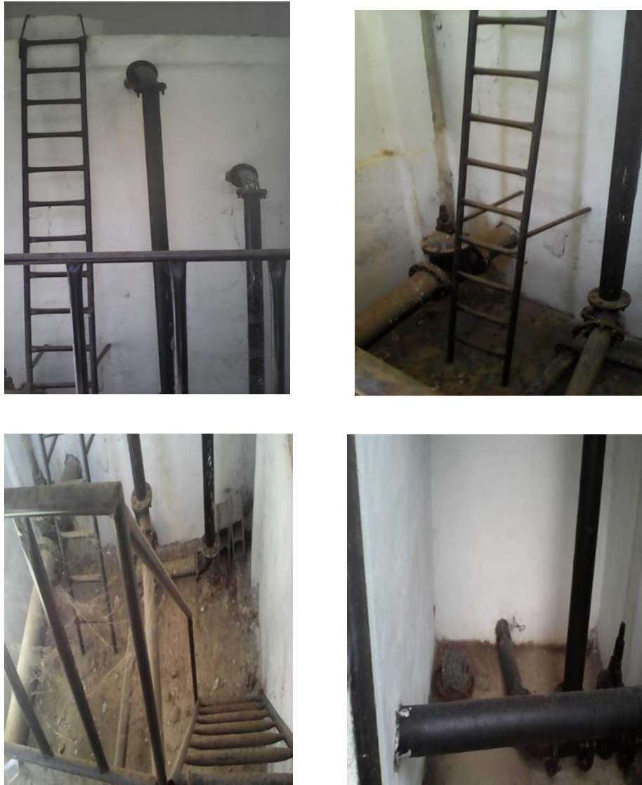
Figure (I.4) : état actuel du réservoir existant 200m 3
