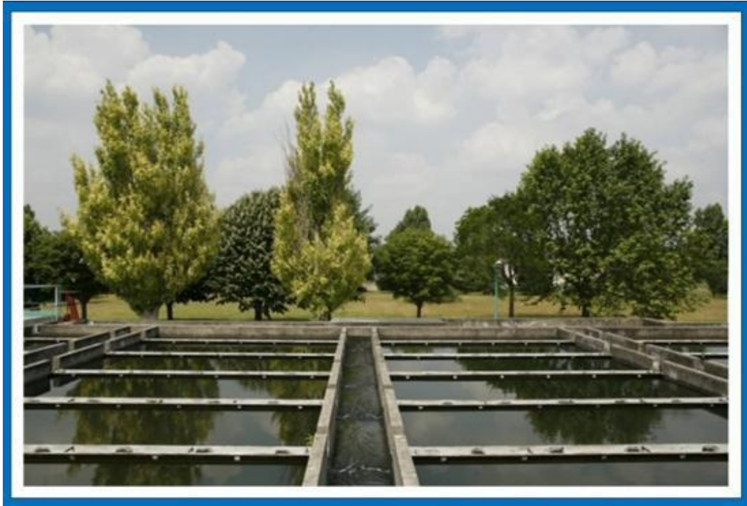
Figure (II.5) : Bassins de décantation
