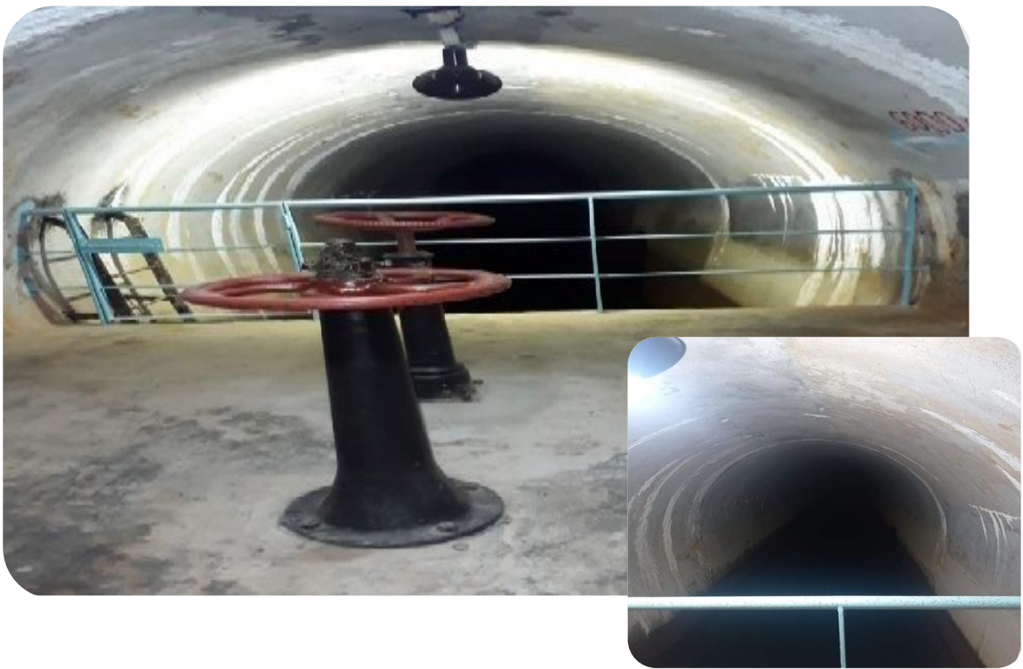
Figure (III.8) : La deuxième galerie de la station
