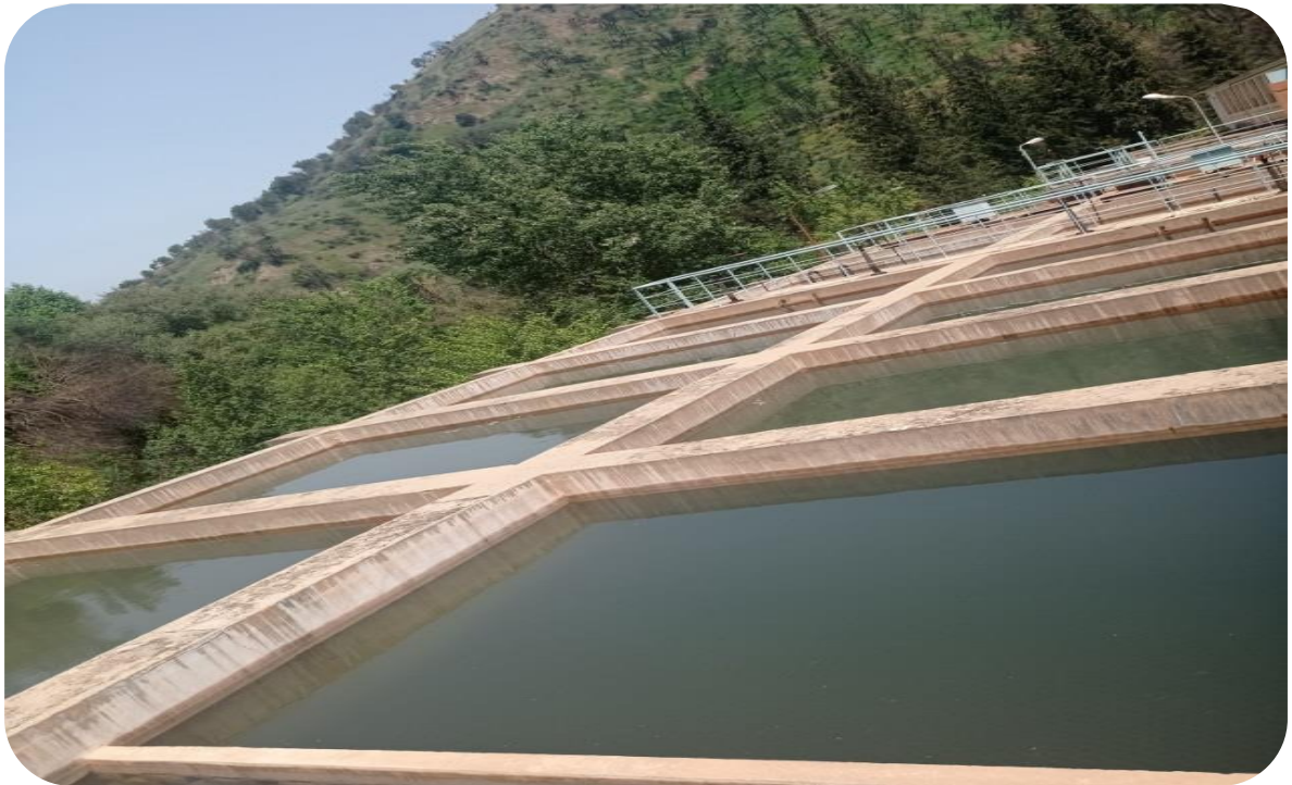
Figure (III.14) : Bassins de décantation
