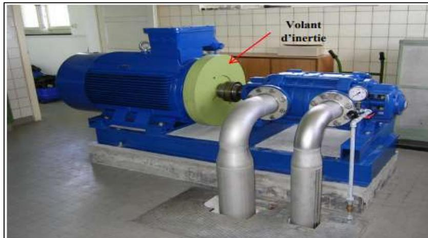
*Figure (VII-1) : Volant d'inertie*
