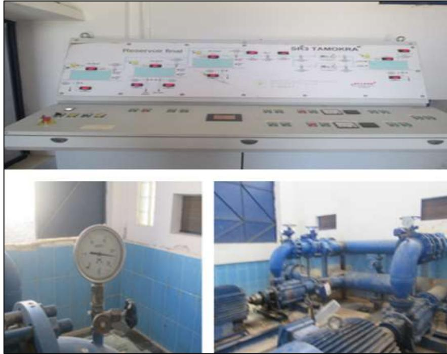
*Figure (II-9) : Equipements électriques et hydromécaniques de la SR3*
