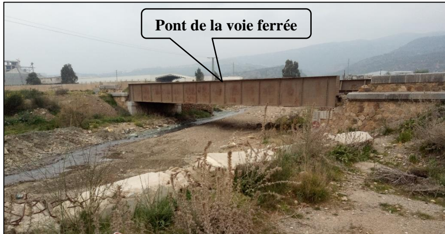
Figure (III.13) : Pont de la voie ferrée traversant oued TIFRIT (Ph. Prises le 28/05/2022).
