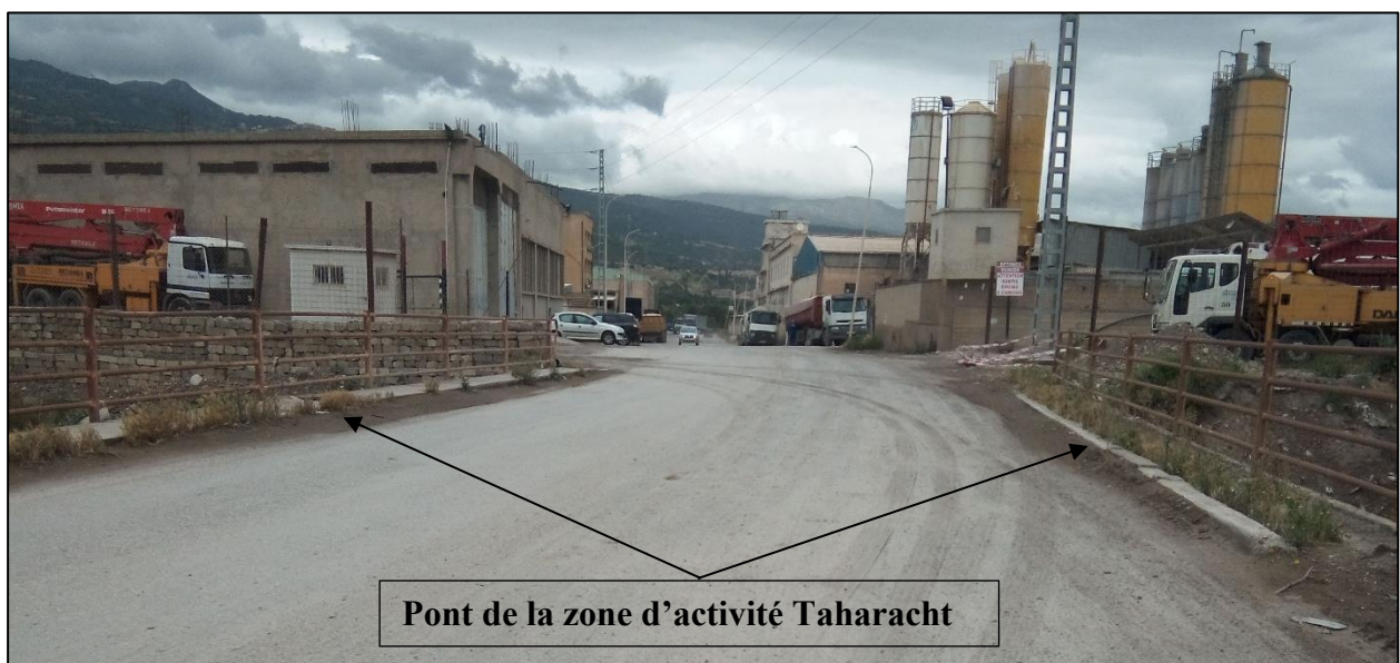
Figure (III.12) : Pont de la zone d'activité traversant oued TIFRIT (Ph. Prises le 28/05/2022).
