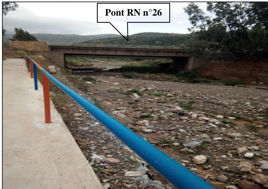
Figure (III.11) : Pont franchi par la RN n°26 traversant oued TIFRIT (Ph. Prises le 28/05/2022).
