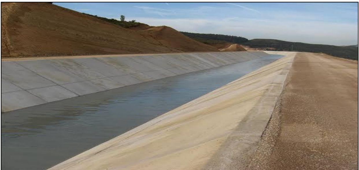
Figure (IV.5) : Canal en béton armé (Image tirée du web).
