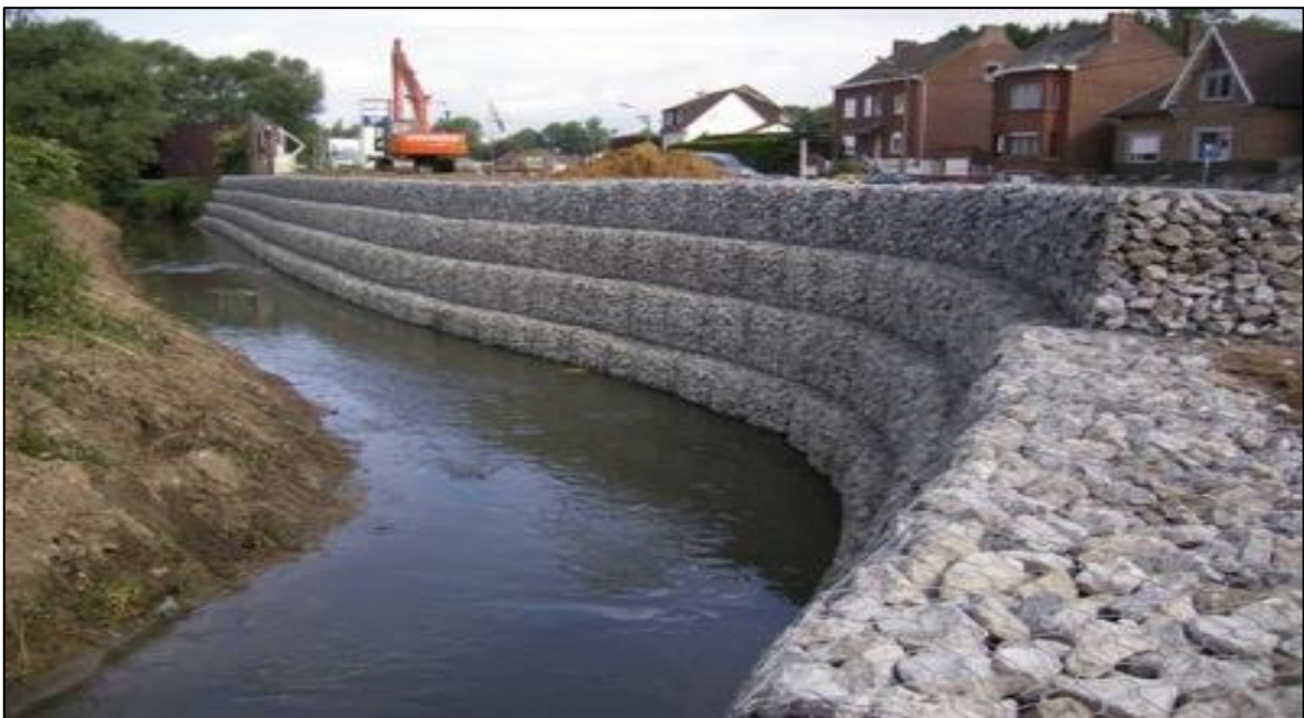
Figure (IV.1) : Mur de soutènement en gabionnage (Image tirée du web).
