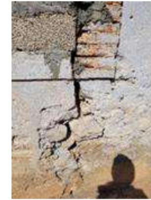
Figure 103: fissuration des murs par effet de choqué sismique
