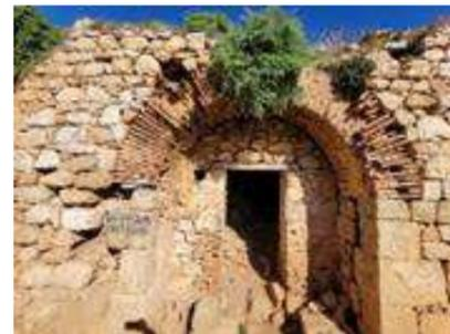
Figure 111 présence d'efflorescence dans les joint des briques ce qui mène à leurs détachement
