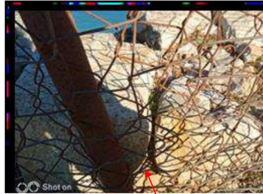
Figure 112: corrosion du fer existant dû à l'exposition à l'humidité extérieure
