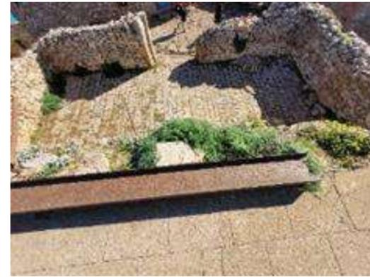
Figure 102: effondrement de la partie supérieure de la caserne par infiltration des eaux sur la toiture ce qui rend le mur plus faible
