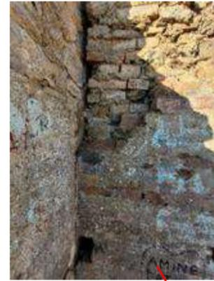
Figure 105: détachement du à la différence de charge entre des murs transversaux
