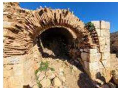
Figure 109: détachement des briques dans les voutes
