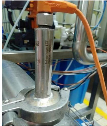
Figure 13 : Image d'une sonde de température
