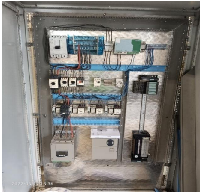
Figure I-20 : Organes de commande et de puissance
