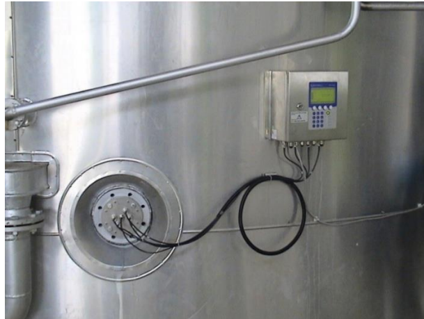
Figure I-18 : Brixmètre
