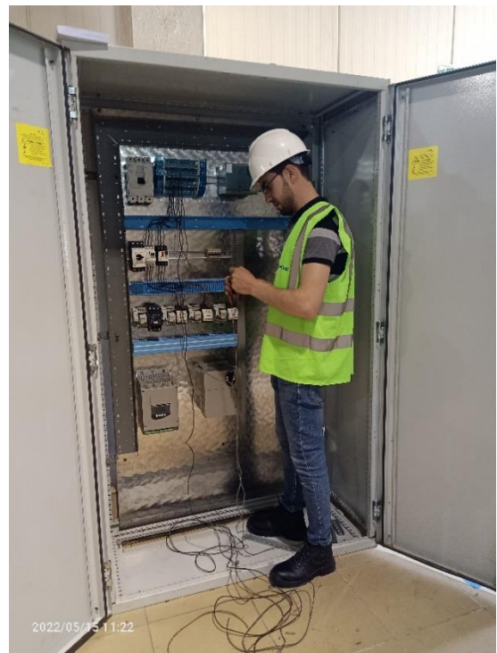
Figure II- 18 : Quelques photos lors de la réalisation de l'armoire électrique de la station
