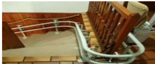
Figure II.12 : Système à deux rails
