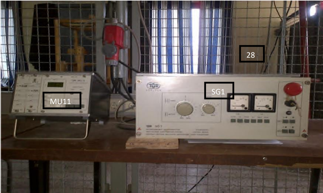
Figure II. 3 : Equipements de l'installation haute tension utilisée.
