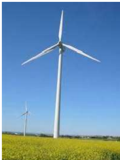
Figure I.6 : Eolienne à axe horizontal
