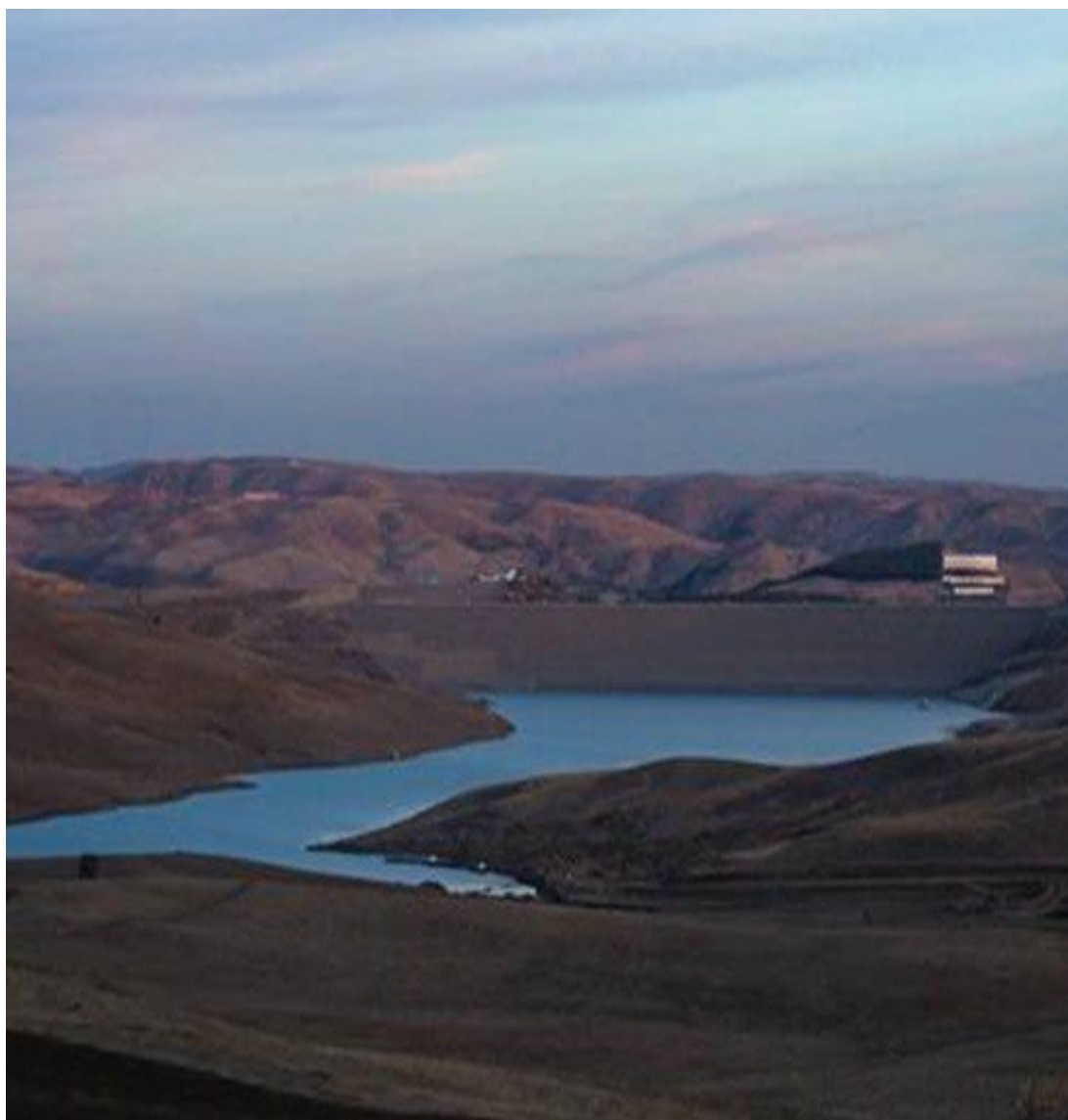
Figure. I.3. Barrage El Maouane.
