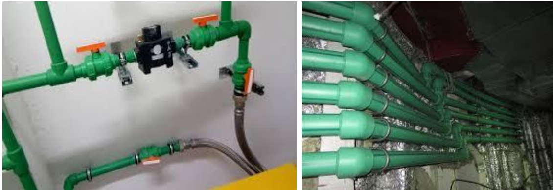
Figure I.27 : installation des tubes en PPR (Polypropylène Random) [11].
