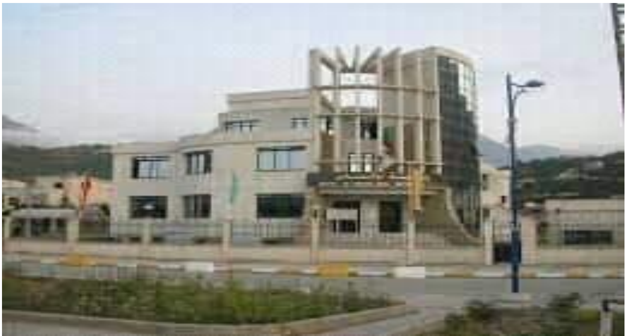
Cellule de communication d'APC d'AOKAS
