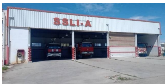
Figure 1-7 : Service de sauvetage de la lutte contre l'incendie
