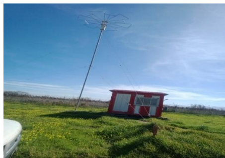
Figure 2-6 : Station de l'aérodrome de BJA
