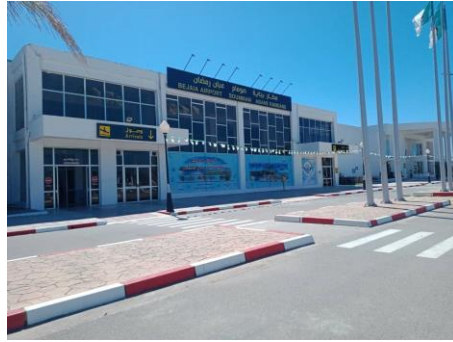
Figure 1-1: La façade de l'aéroport de Bejaia
