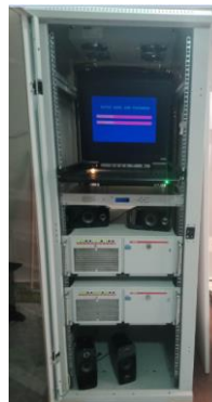
Figure 2-38 : Systèmes d'enregistrement des communications
