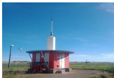
Figure 2-18 : Station VOR de l'aérodrome de Bejaia
