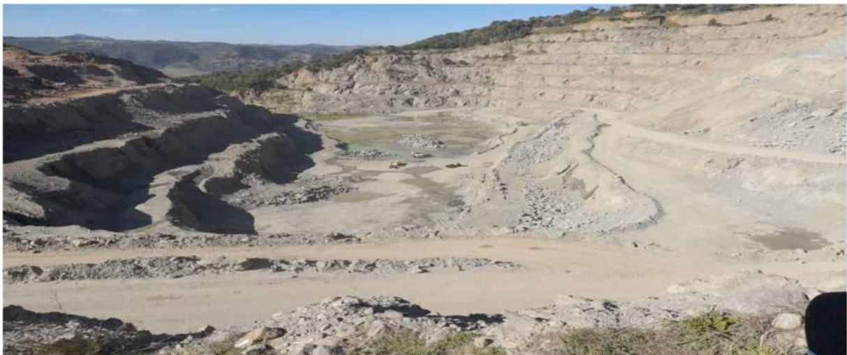
Figure 9. La méthode d'exploitation utilise par la carrière (par fosse) (mars 2023)
