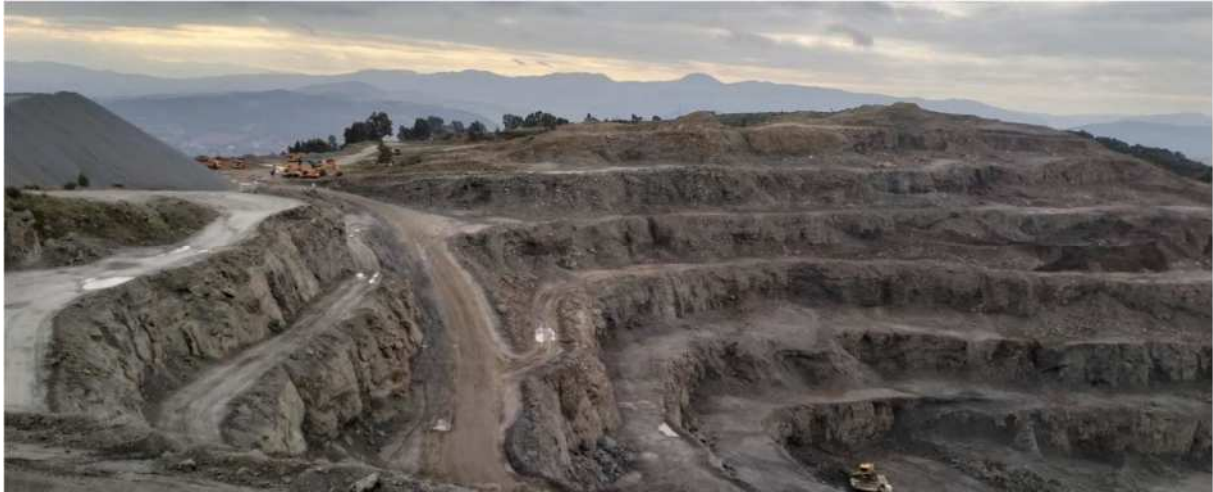
Figure 10. Image représentent tranchée d'accès. (mars 2023).
