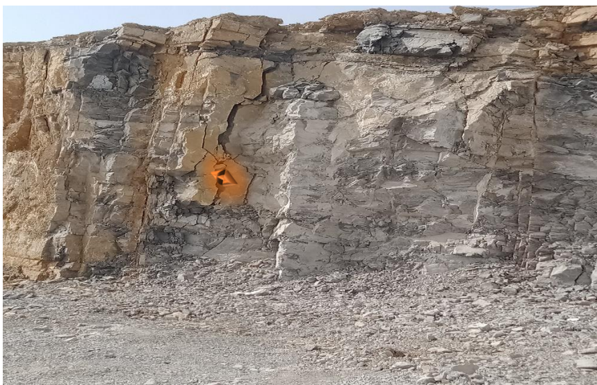
Figure II.14: la fissuration du massif rocheux.
