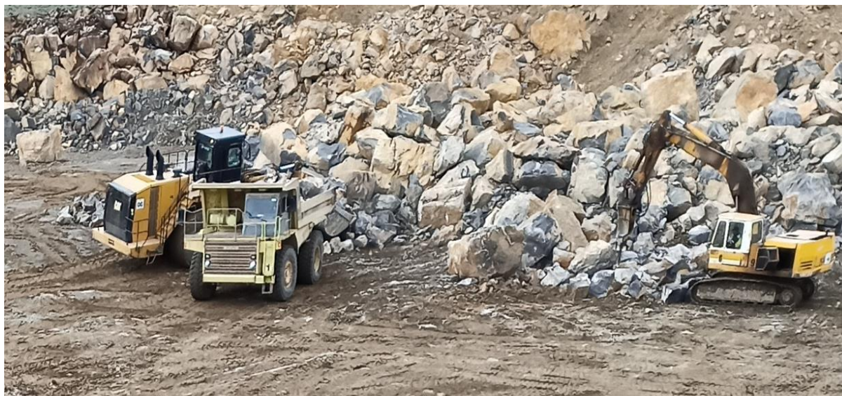
Figure II.15 : débitage secondaire assuré avec une pelle hydraulique
