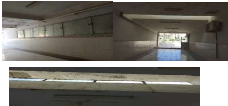
Figure B 5: photos réelles de l'intérieur du hall d'exposition entre les amphithéâtres 22/23/24.auteur (2023)
