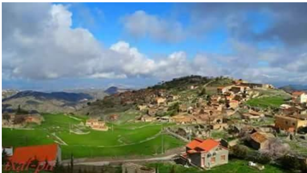
Photographie N°3: l'architecture du village El Kalaa
