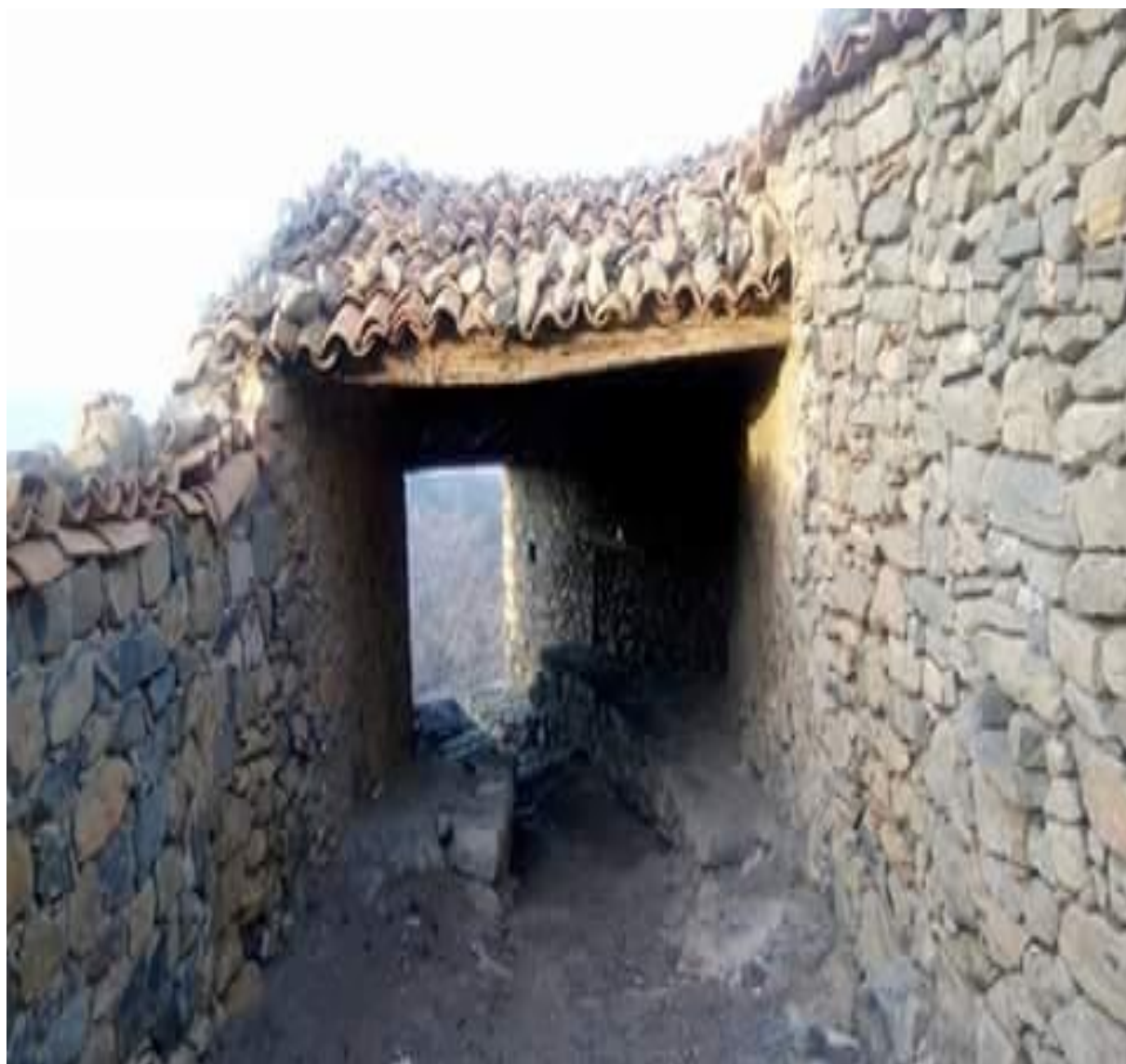
Photographie N°5 : le passage couvert
