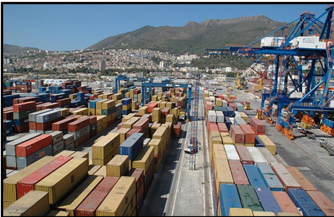
Figure I-3 : Entreposage des Conteneurs EPB
