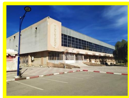
Figure 23: bibliothèque centrale du campus Targa Ouzemour (auteur, 2023)
