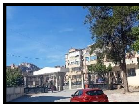
Figure 34: poste de sécurité à
